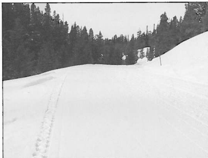
Photo 1.8 Le damage de piste sert à former une base résistante et compactée
